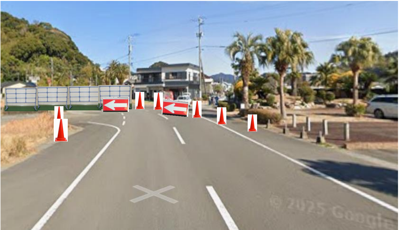
■誘導矢印設置、カラーコーンでコースライン、コースマーシャルによる注意喚起。
